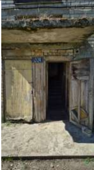
Kāpņu telpas ārdurvis
